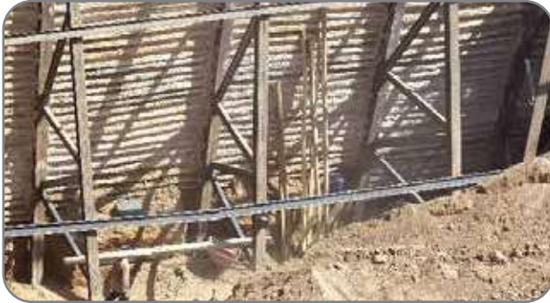
گام دوازدهم: نصب اعضای بادبندی و قطری جهت عملکرد فضایی خرپا.
