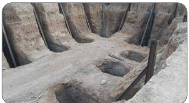
ستون قائم خرپا. گام یازدهم: برداشت خاک قسمت شیبدار از بالای گود به صورت مرحله به مرحله و اجرای المان افقی بین دو خرپا از بالا به پایین و تکمیل اعضای داخلی خرپا. در سیستم خرابایی فاصله بین خرپاها را بایستی از بالا به سمت
