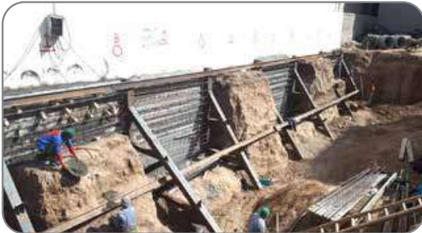
گام دوازدهم: نصب اعضای بادبندی و قطری جهت عملکرد فضایی خرپا.
