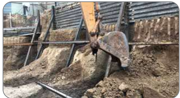
ستون قائم خرپا. گام یازدهم: برداشت خاک قسمت شیبدار از بالای گود به صورت مرحله به مرحله و اجرای المان افقی بین دو خرپا از بالا به پایین و تکمیل اعضای داخلی خرپا. در سیستم خرابایی فاصله بین خرپاها را بایستی از بالا به سمت
